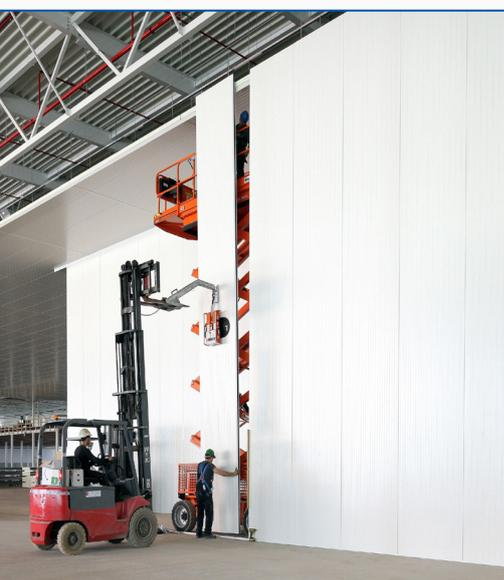
**Núcleo aislante rígido de lana de roca con un alto rendimiento térmico (conductividad térmica de tan solo 0,042 W/mK).**
