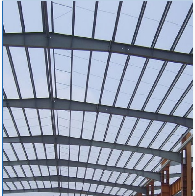
Estructura de soporte de cerramientos
